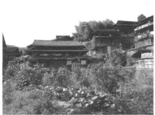
图3 同乐乡高武屯郑利斌家的木屋 (左下方是正在修建中的新房)
