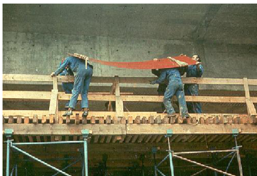
Figure I.1. 9: Tôles collées ; (a) difficulté de manutention ; (b) Renforcement du viaduc de Terrenoire par tôles collées perforées -Brevet Freyssinet- (Luyckx 1999)
