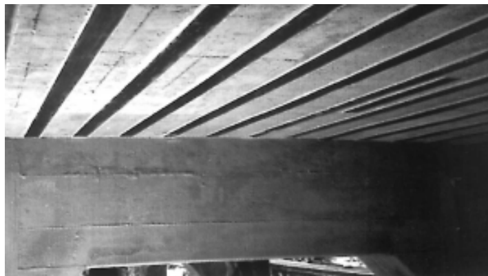
Figure I.2. 7: Procédé par collage de plaques (Sika 1998)
