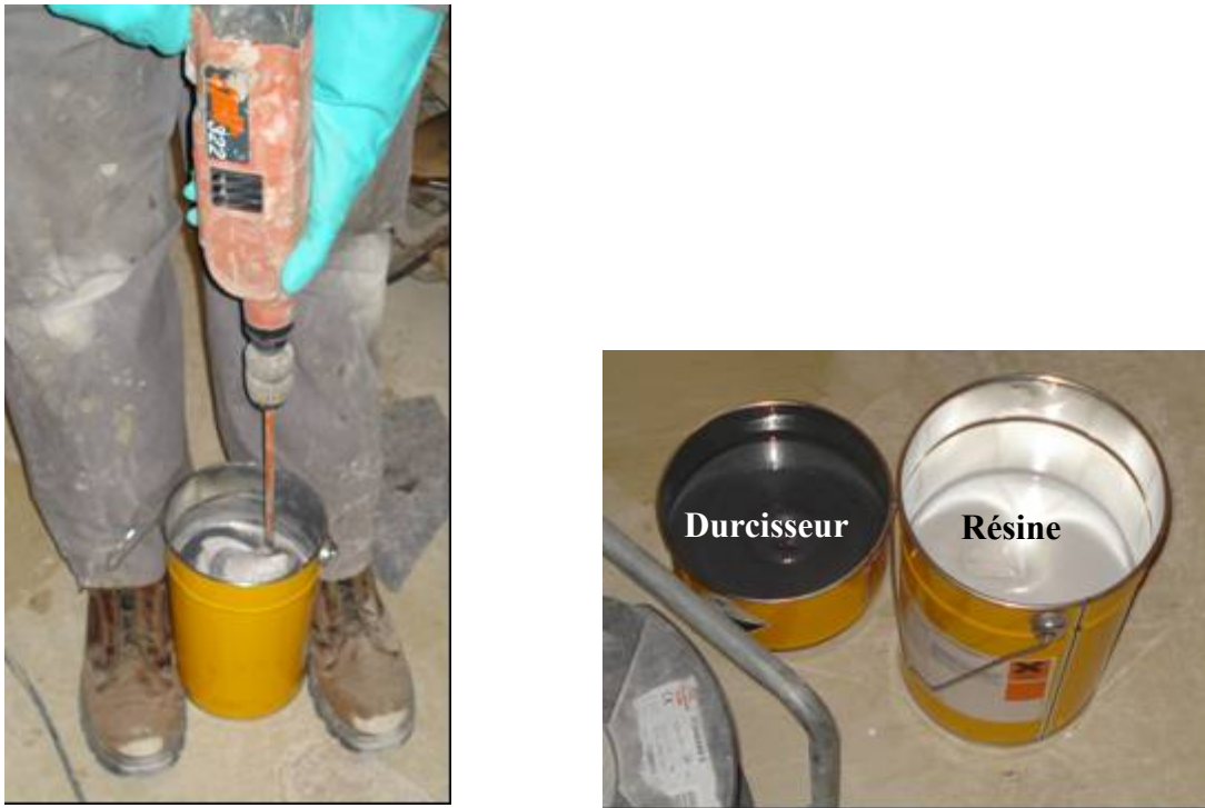
Figure II.2. 2: Résine époxy d'imprégnation (Sikadur-330) pour tissu de renforcement
