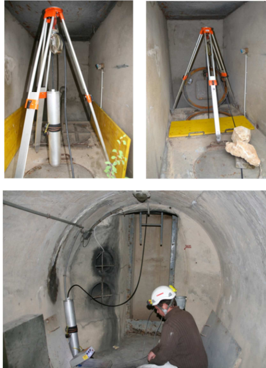
Figure 88: Configuration du puits de 30 mètres utilisé pour des mesures de détection du CO 2
