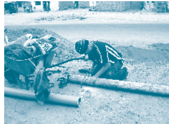
Los estudios permitieron comprobar que gran parte de la infraestructura podía rehabilitarse.
