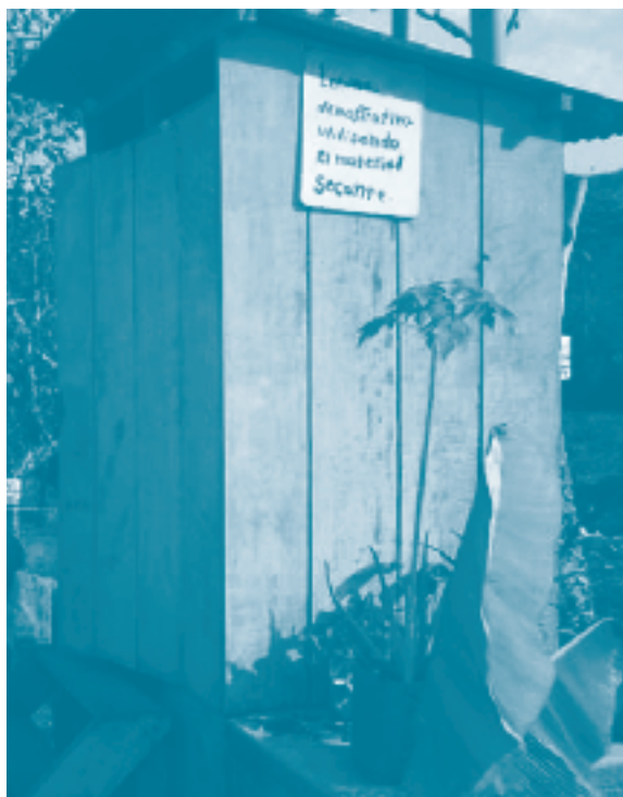
Letrina a la que se ha adaptado el uso de material secante.
