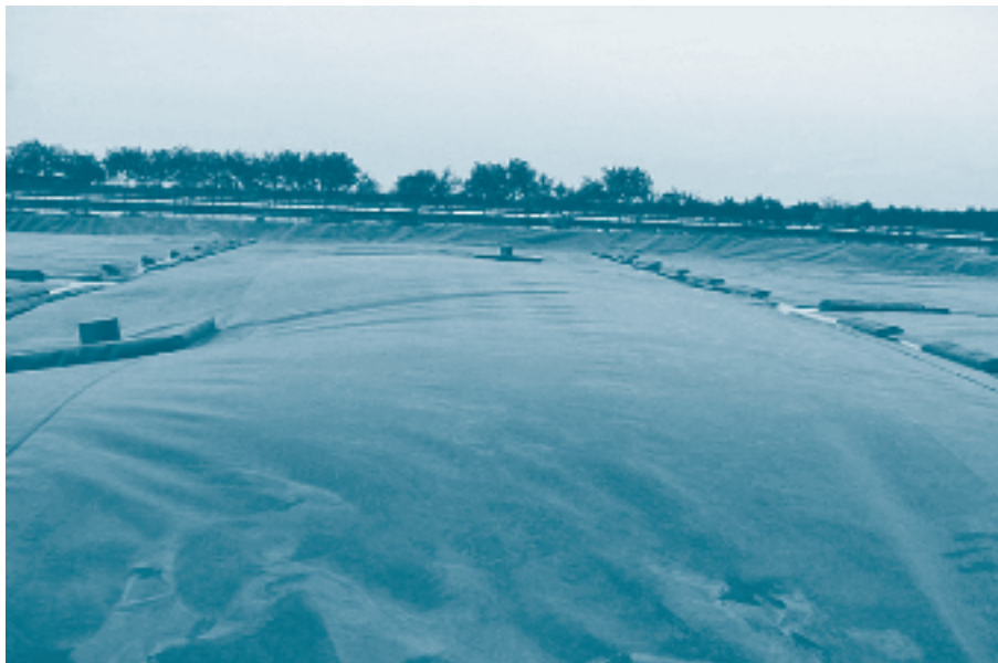
Figura 8: Cubierta instalada en la planta del Parque Industrial
