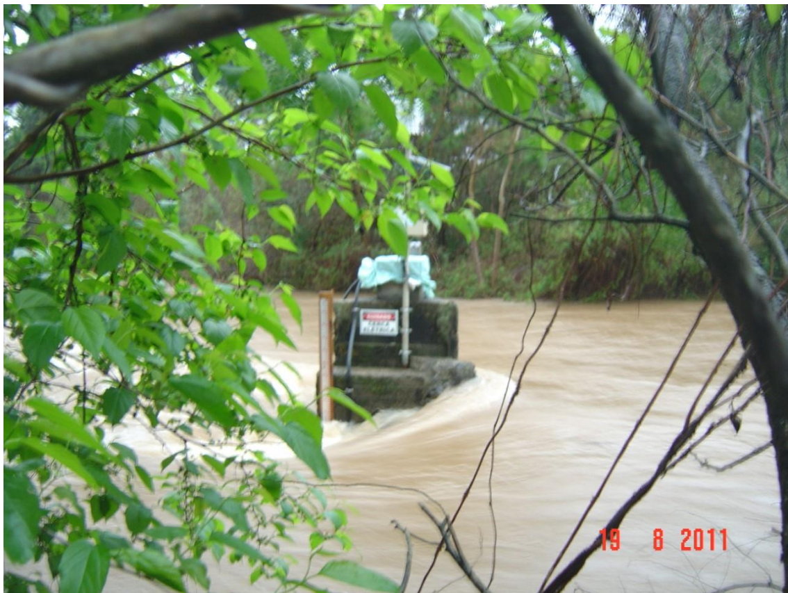
Figura 5-7 - Vista de la estación fluviométrica en una crecida.
