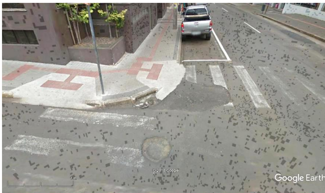
Figura 5-19 - Visualización de bocas de tormenta de la localidad de Guarapuava en Street View.
