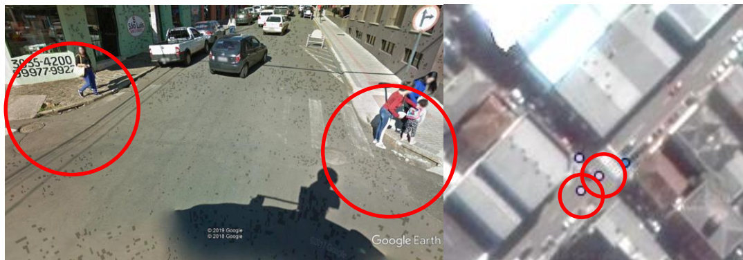
Figura 5-24 - Detalle de bocas de diferencias entre bocas tormenta relevadas por Street View y verificadas in situ. Verificación en Street View.
