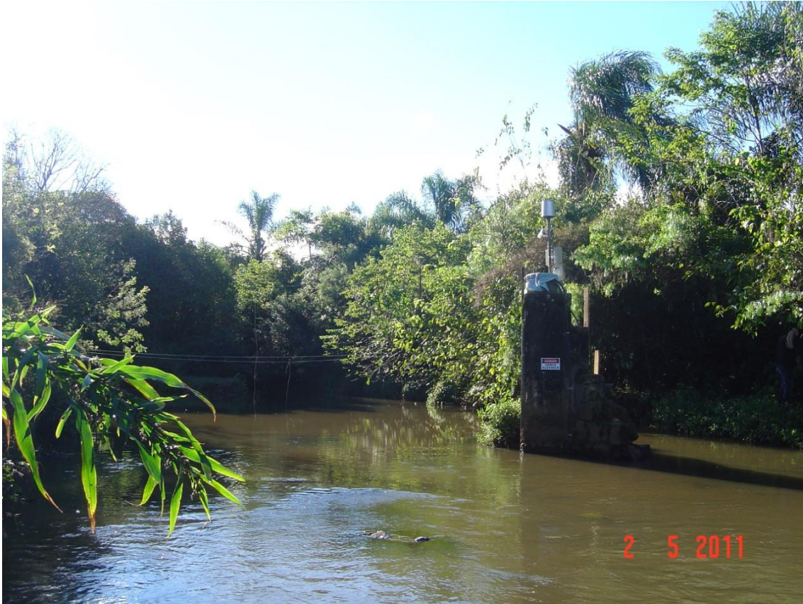
Figura 5-10 - Vista desde aguas abajo hacia aguas arriba de estación fluviométrica.
