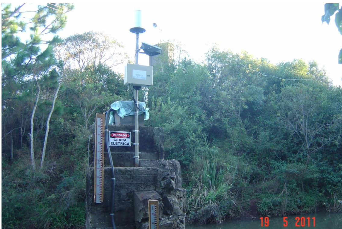
Figura 5-9 - Vista en detalle de la estación fluviométrica.
