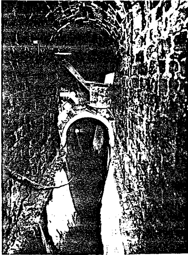
Figure 19 : Revêtement par segments en "Gunite"
