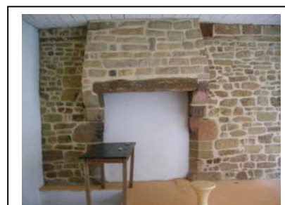
Cheminée du N°31 rue du Château, rez-de-chaussée.
