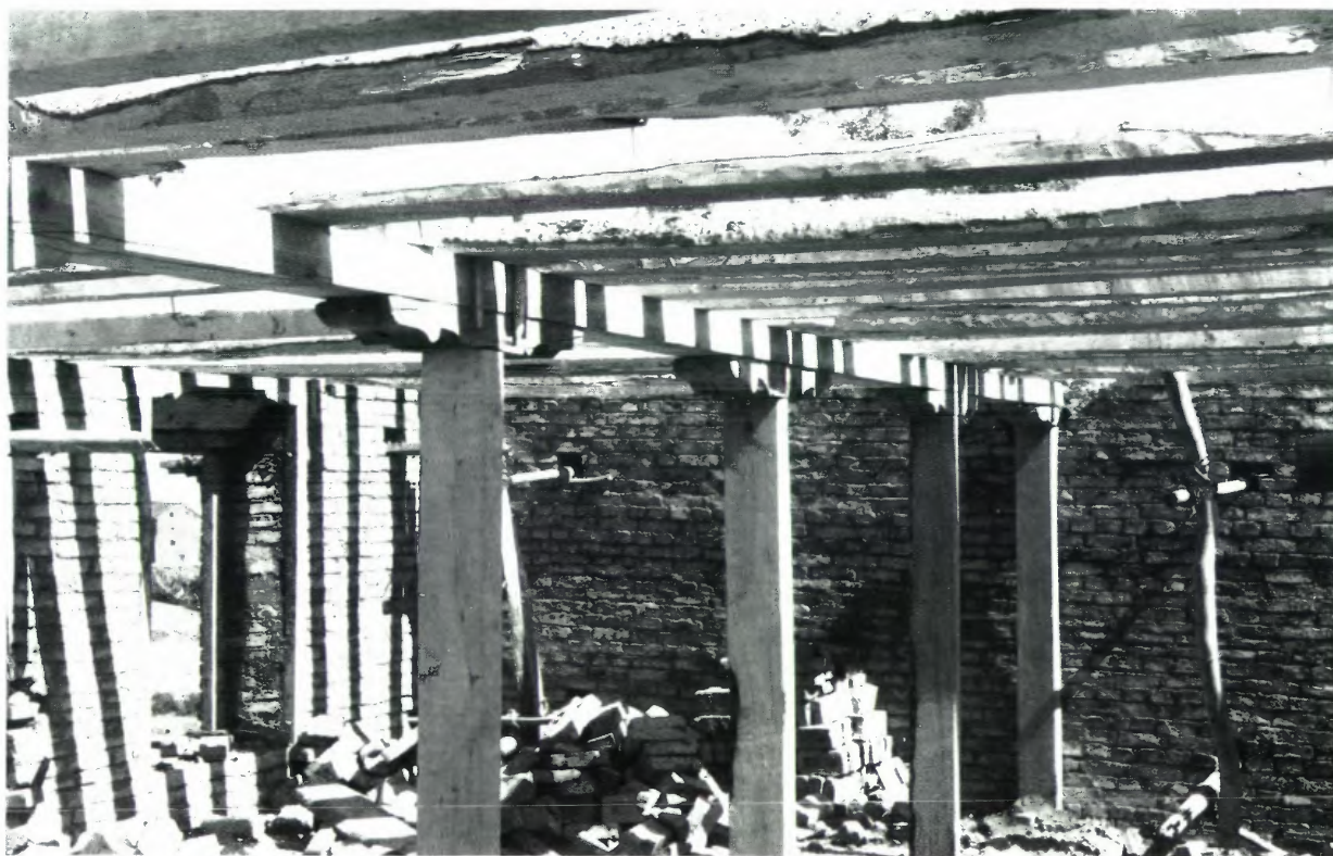
44. Piliers, poutres et solives.
