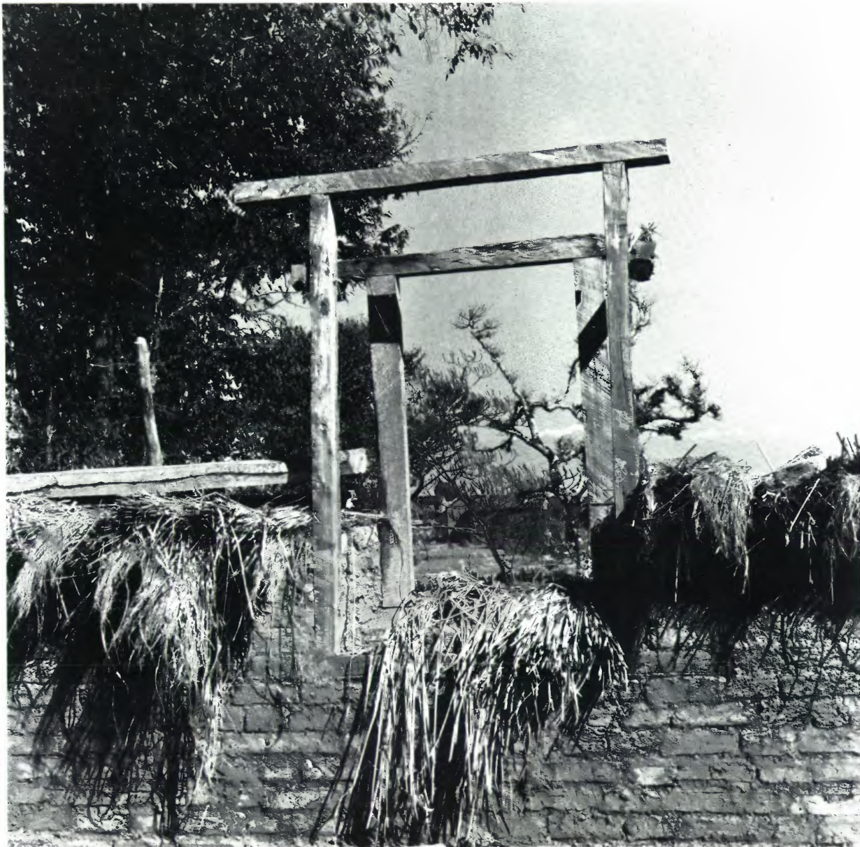
42. Construction d'une fenêtre : mise en place d'un bâti
