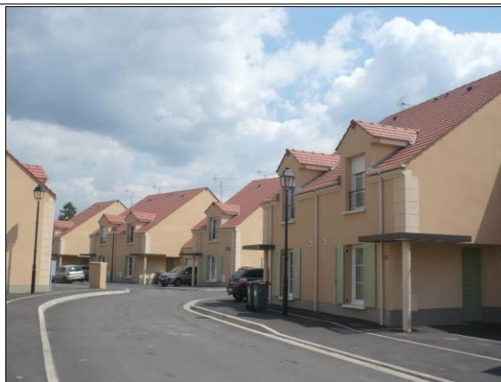
Figure 49. Les Flaches Ouest, logements sociaux « en bande »
