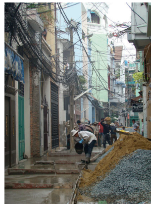
Giai đoạn 3 : Công ty xây dựng do Chính quyền chỉ định thi công mở rộng lộ giới: lắp đặt hệ thống cống và nâng hẻm khi làm đường
