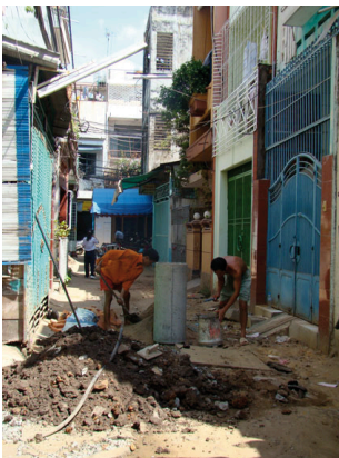
Giai đoạn 3 : Công ty xây dựng do Chính quyền chỉ định thi công mở rộng lộ giới: lắp đặt hệ thống cống và nâng hẻm khi làm đường
