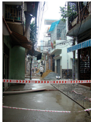
Giai đoạn 3 : Công ty xây dựng do Chính quyền chỉ định thi công mở rộng lộ giới: lắp đặt hệ thống cống và nâng hẻm khi làm đường
