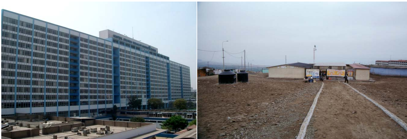
Photos n°32 et 33 : Hôpital Rebagliati (EsSalud), le plus grand de Lima, et centre de santé de Bahia Blanca (Minsa) à Pachacutec
