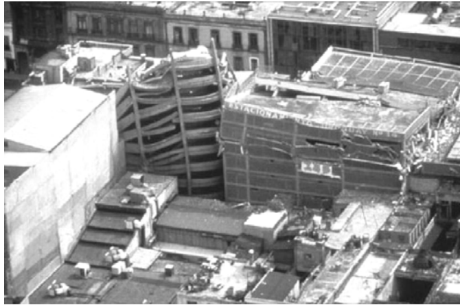
Photo n°2 : Séisme de 1985 à Mexico : effondrement vertical d'un immeuble Source : Boise State University (in Mancebo, 2006a)
