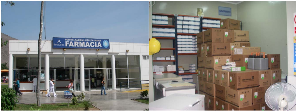
Photos n°41 et 42 : Entrepôt de l'hôpital Hipolito Unanue et stock de médicaments dans l'entrepôt spécialisé de la Diresa Callao
