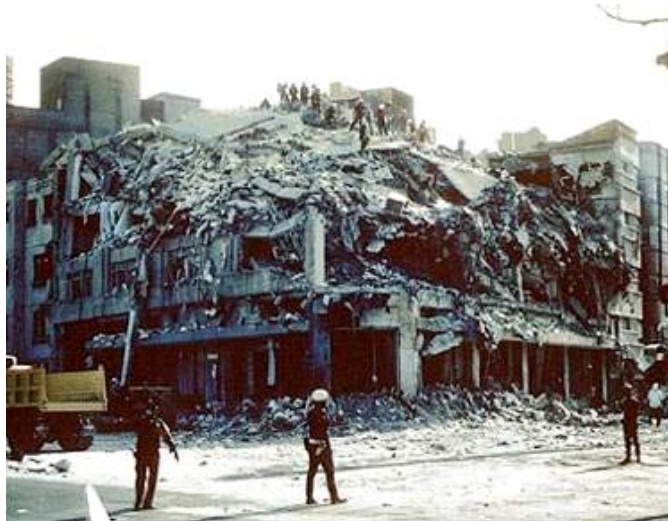
Photo n°1 : Edifice détruit par le séisme de 1985 à Mexico
