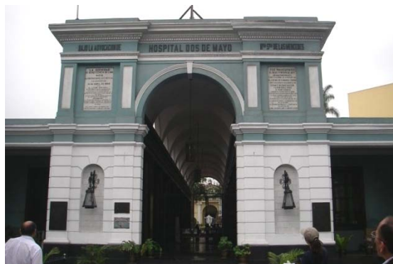
Photo n°85 : Hall d'entrée de l'hôpital Dos de Mayo, construit en 1868
