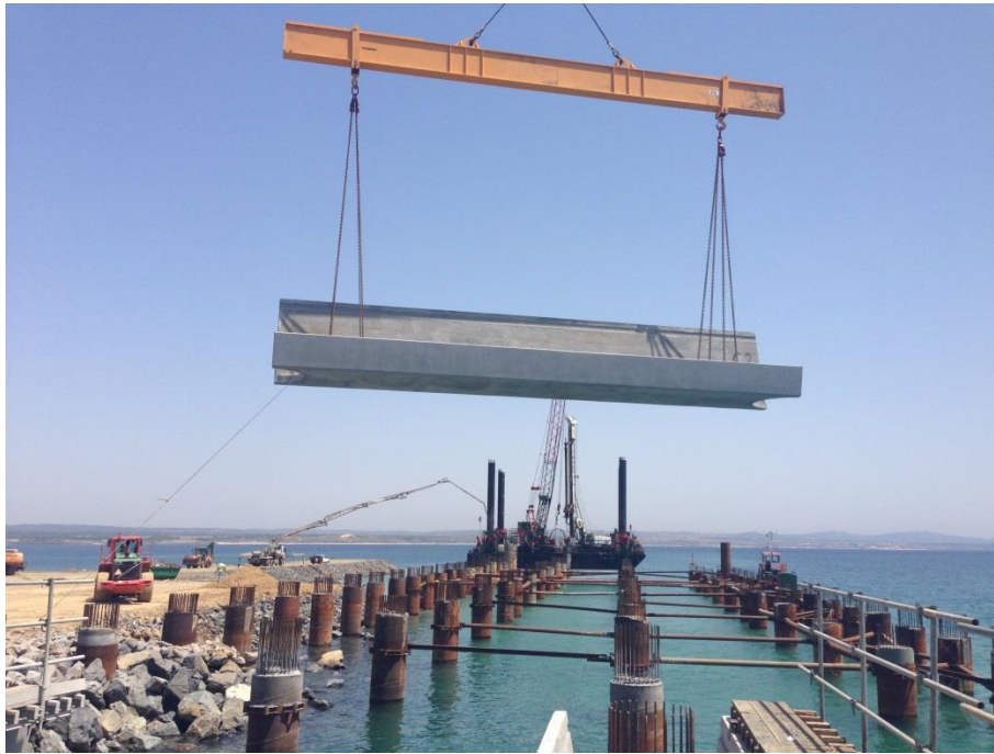
Figura 84 - Colocação do Canaleta alinhamento B com apoio de uma grua de rastos e de uma balança do tipo spreader
