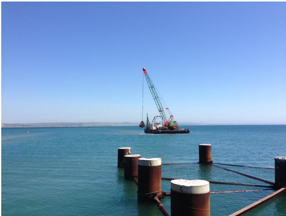
Figura 60 – Dragagem com draga de mandibula Clamshell na plataforma flutuante “Cabo de São Vicente” - Arquivo Pessoal (22-04-2014)
