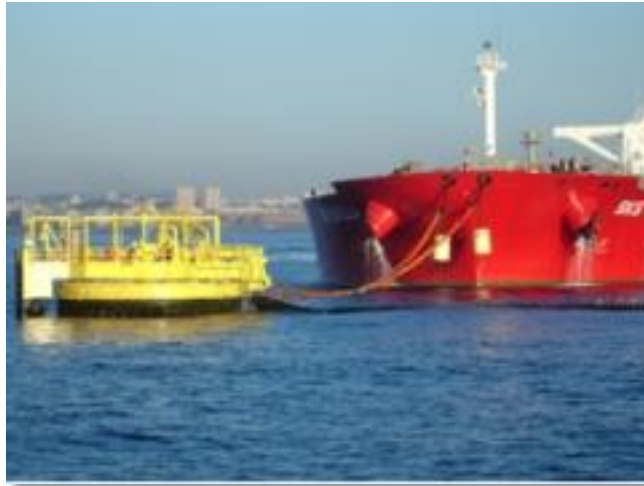
Figura 16 – Terminal Oceânico – Monobóia [14]
