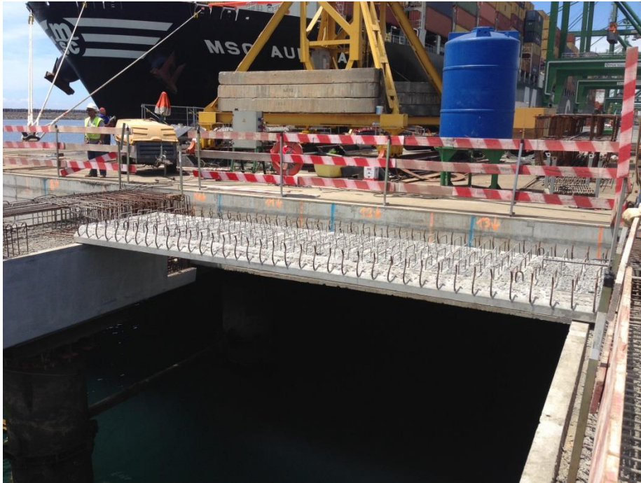
Figura 86 - Aspecto final das Pré-lajes
