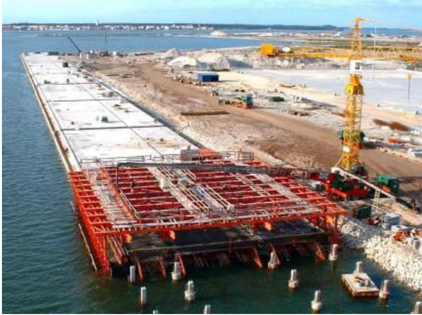
Figura 55 - Vista geral dos trabalhos no porto de Aveiro [12]
