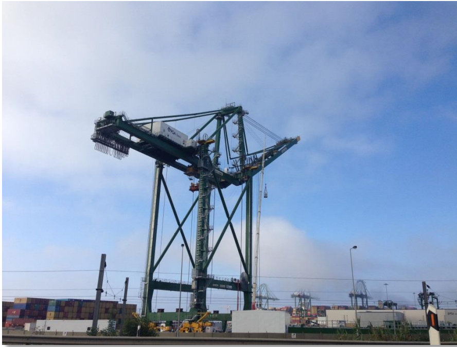
Figura 38 - Montagem do pórtico “Post panamax”, arquivo pessoal
