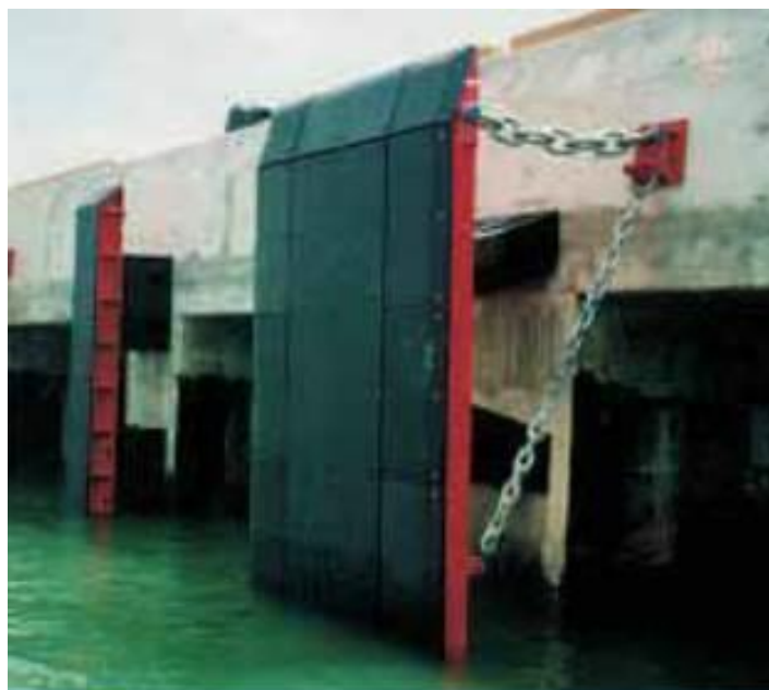
Figura 24 - Defesa Tipo modular
