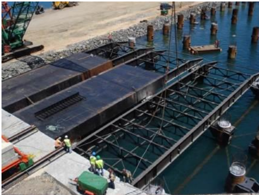
Figura 53 - Montagem do cimbra móvel [12]
