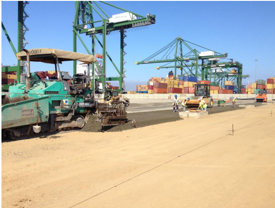
Figura 109 - Compactação e regularização da camada de sub-base
