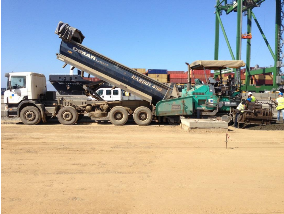
Figura 108 - Execução da camada de sub-base em AGE C
