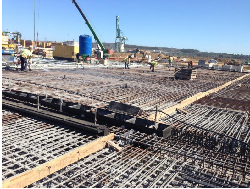
Figura 89- Moldagem "in situ" da armadura da laje do tabuleiro
