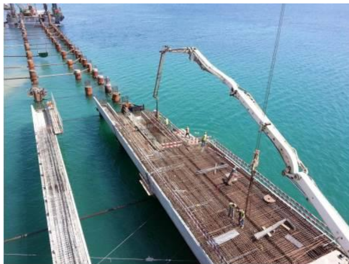
Figura 85 - Betonagem da viga A
