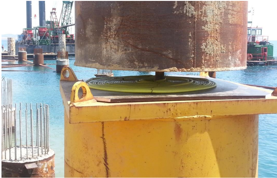
Figura 76 - Equipamento de aplicação de impacto - martelo e amortecedor [28]
