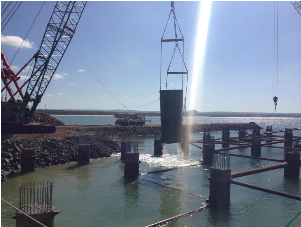
Figura 79 - Colocação de TOT com a caçamba
