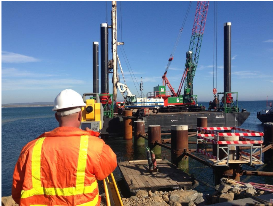
Figura 65- Posicionamento da camisa metálica, arquivo pessoal (06-05-2014)
