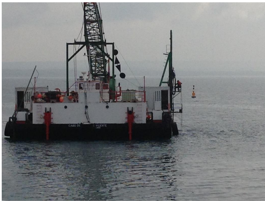
Figura 61 - Execução dos furos para posterior introdução de explosivos, na embarcação "Cabo de São Vicente" - Arquivo Pessoal (22-04-2014)
