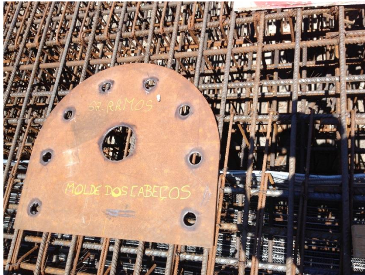
Figura 91 - Negativo para o cabeço de amarração
