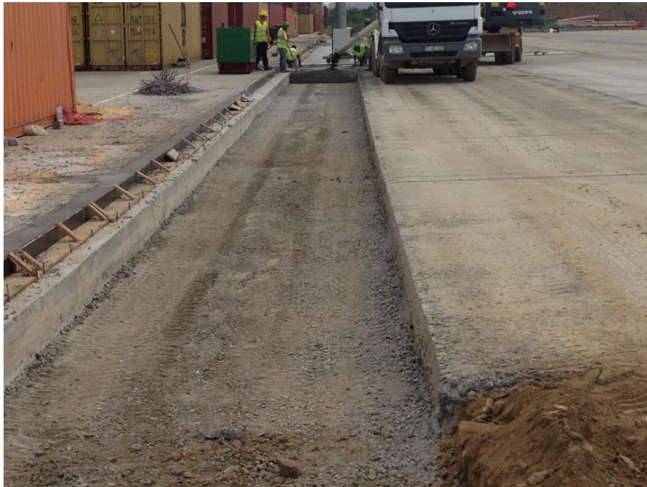
Figura 111 - Execução da laje em betão, sem auxílio da pavimentadora
