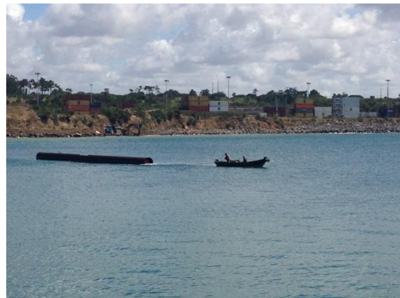
Figura 64 - Transporte das Estacas por via marítima com apoio da lancha "calhau", arquivo pessoal (22-05-2014)
