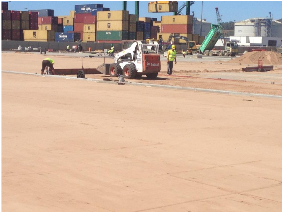
Figura 112 - Colocação da camada de areia
