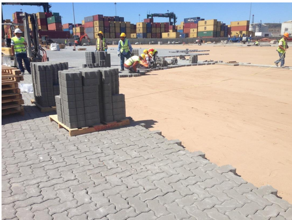
Figura 113 - Colocação manual de "PAVE"
