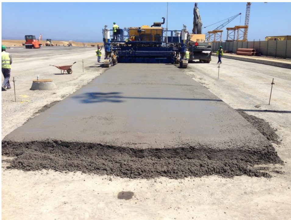
Figura 110 - Execução da laje em betão com auxílio da pavimentadora
