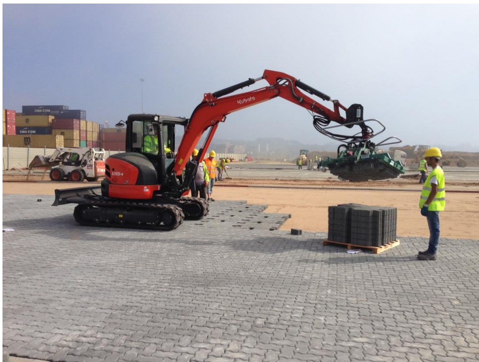
Figura 114 - Colocação de "PAVE" com auxílio da mini-escavadora adaptada com o acessório para aplicação dos blocos
