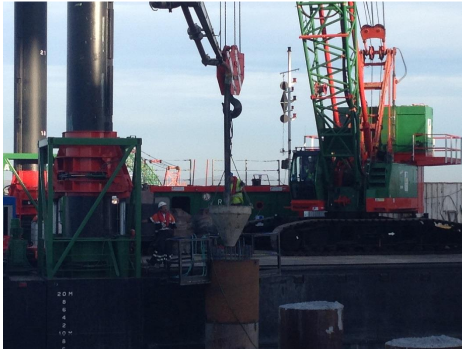
Figura 72 - Betonagem Estacas, arquivo pessoal (07-05-2014)
