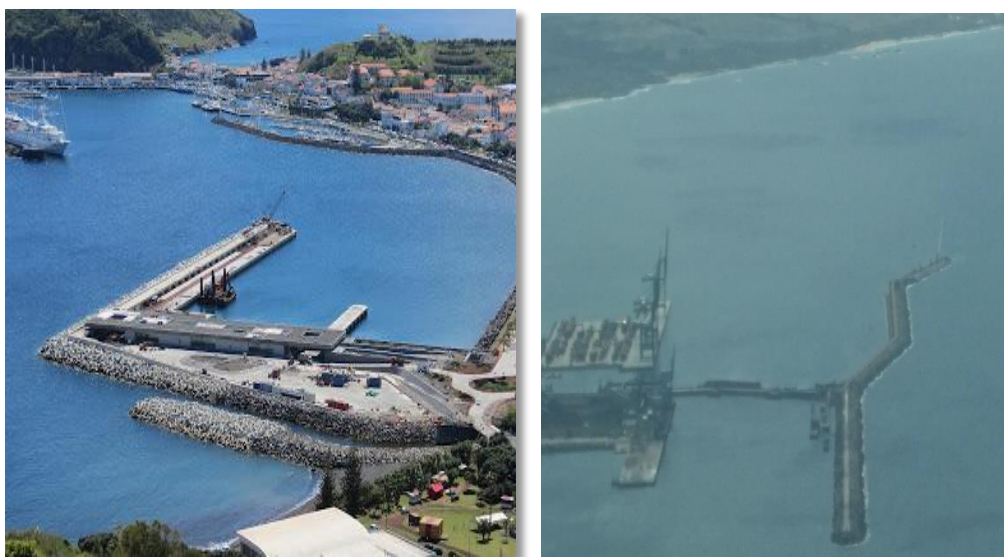
Figura 6 - Exemplos de quebra-mar com estrutura de carga e descarga (porto da Horta) [10] e quebra-mar sem estrutura de carga e descarga (molhe leste, porto de Sines) [11]
