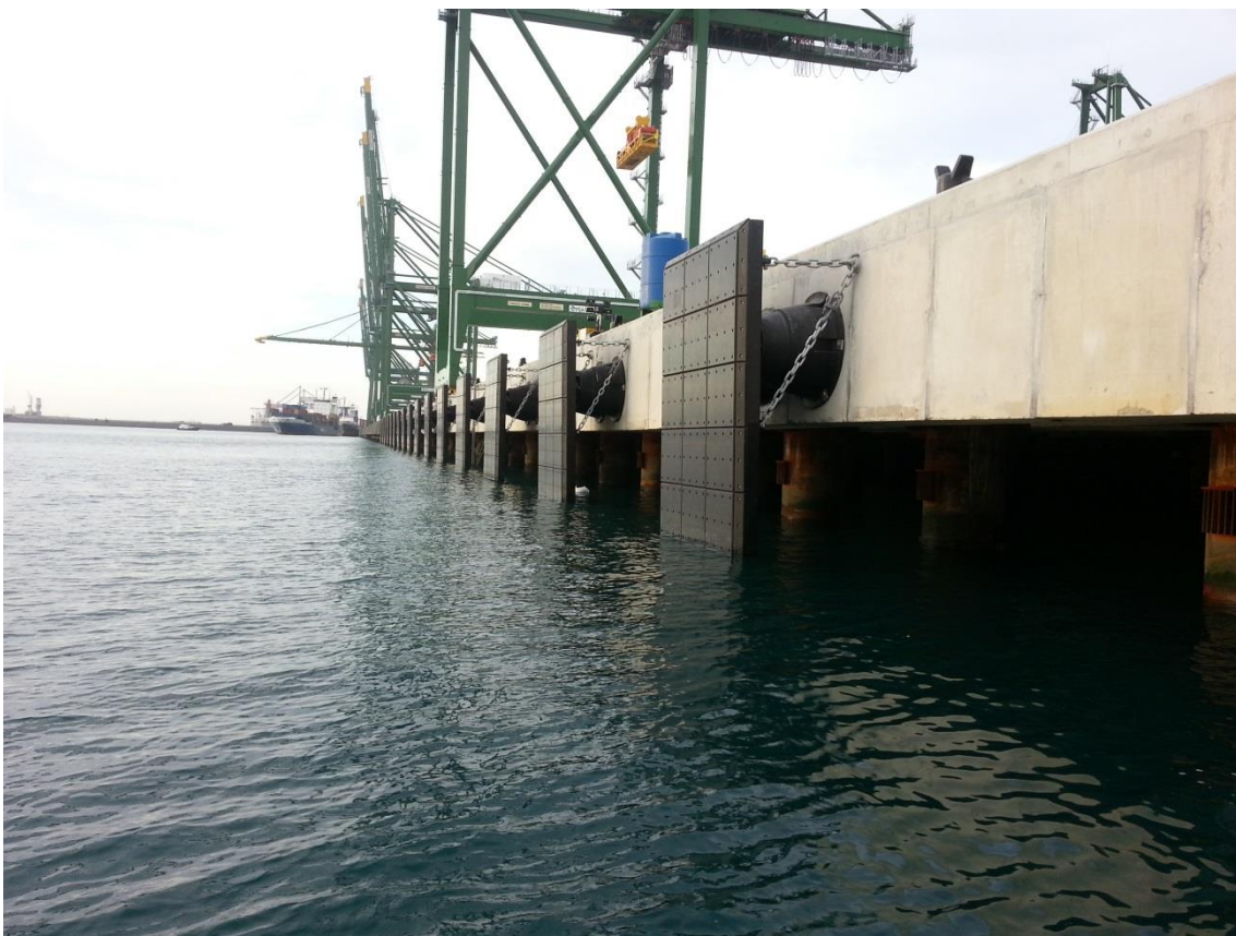
Figura 98 - Aspecto final do cais
