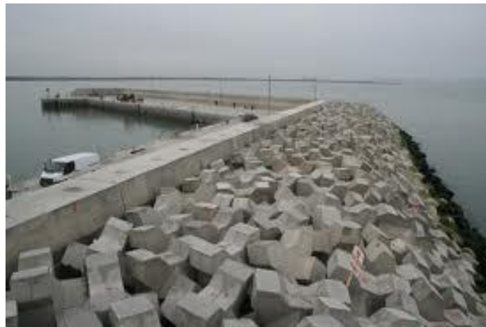
Figura 8- Exemplo de um Quebra-mar em talude
