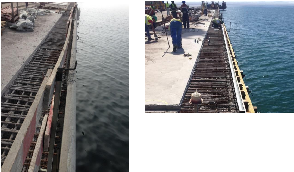
Figura 96 – A: bordadura do cais antes dos trabalhos de correcção; B: Aspecto final da bordadura do cais.
