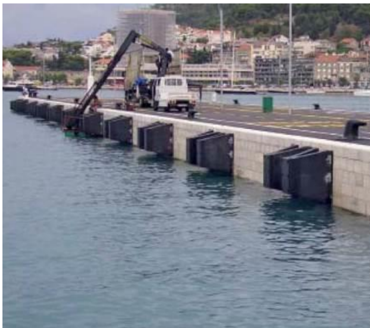
Figura 23 - Defesa tipo Arco
