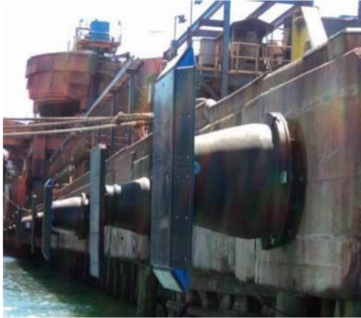
Figura 25 - Defesa Tipo Cone
