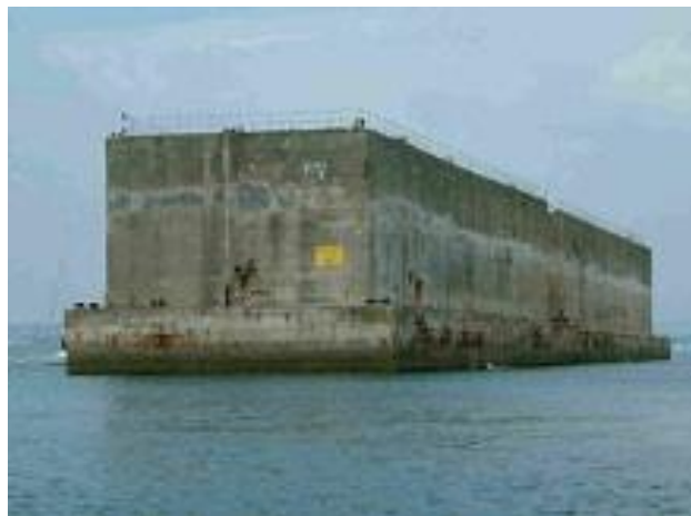
Figura 10 – Exemplo de um Quebra-mar de Paredes Verticais [11]
