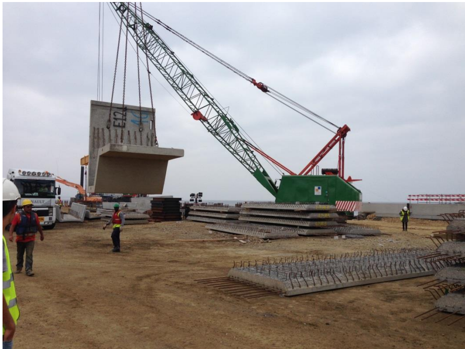
Figura 87 - Painel frontal que irá dar o aspecto final do bordo do cais
