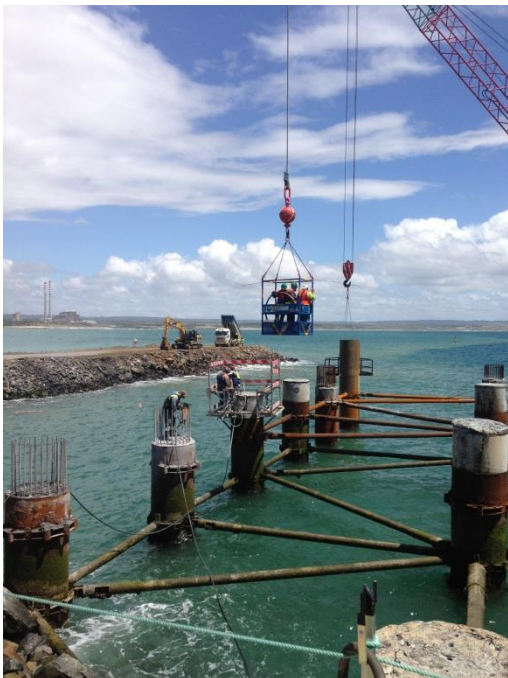
Figura 73 – Saneamento das Estacas e buçins de apoio às vigas pré-fabricadas em betão, arquivo pessoal (02-08-2014)
