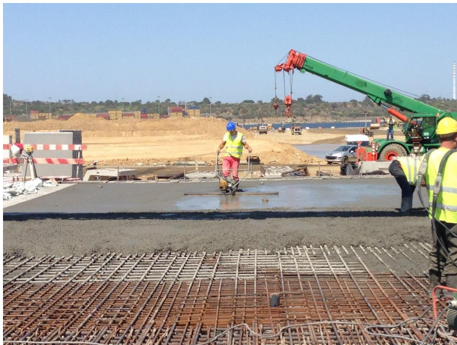
Figura 92 - betonagem do tabuleiro
