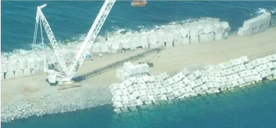
Figura 44 - Disposição aplicada no intradorso na " 2 fase de ampliação do Molhe Leste" [29]
