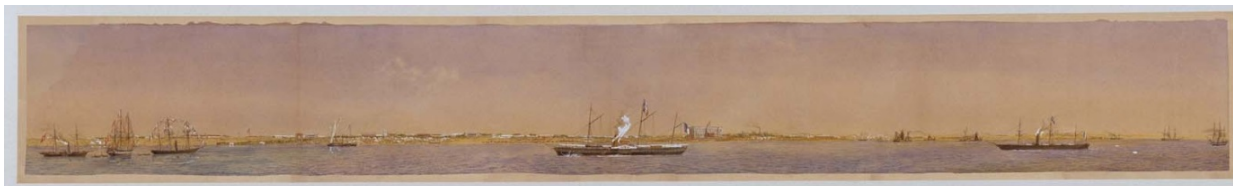
Figure 36 : E. Pâris, Ismaïlia, panorama développé de la ville, vers 1870. MnM, 15 OA 81. © MnM-P. Dantec
