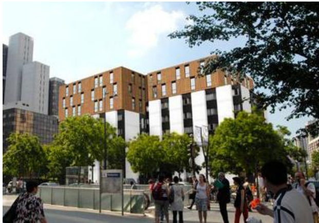
FIGURE 8.3 – FAÇADE DU FOYER C AVEC SURELEVATION
