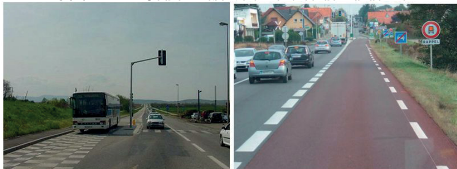
FIGURE D.4 – Couloir réservé à l'entrée de Furdenheim
