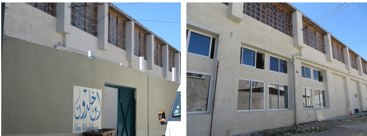
Figure 6 : Illustrations des travaux en cours dans le collège Ibn Khaldoun
