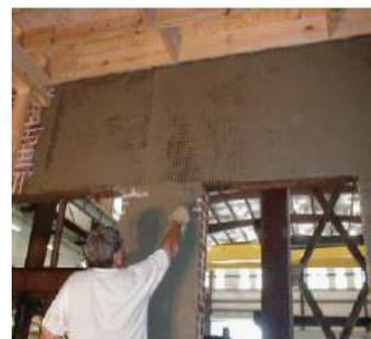
*Renforcement de la maçonnerie par composite TRC*
