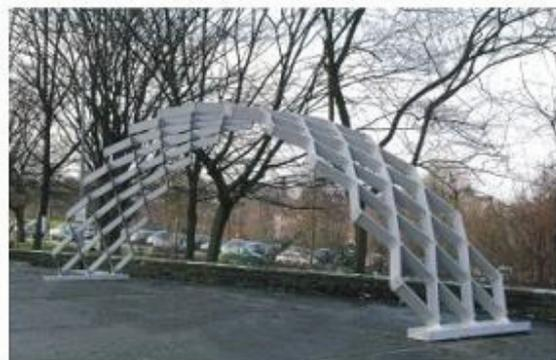
*Structure par assemblage d'éléments rhombiques*
