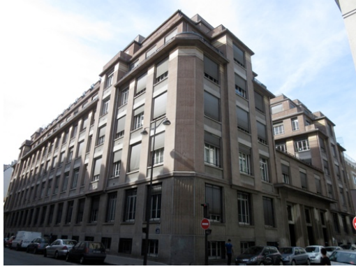
Entretien 67 : Gestionnaire d'infrastructure délégué SNCF, rue Traversière
