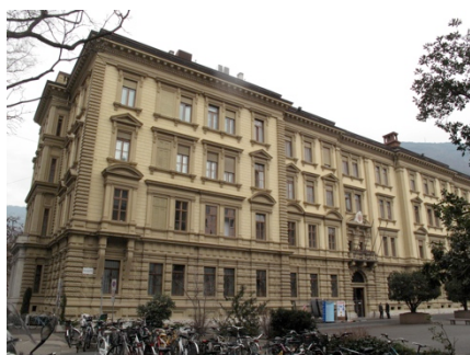
Entretien 49 et 50 : Società ABZ, Palazzo Widmann, Province de Bolzano, Place Silvius Magnago
