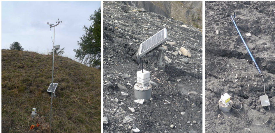
FIGURE 3.4 – Couches capteurs déployées à Super-Sauze. De gauche à droite : station météo, capteur P-T-U, sonde d'étude du sol (photos : O.Martin).
