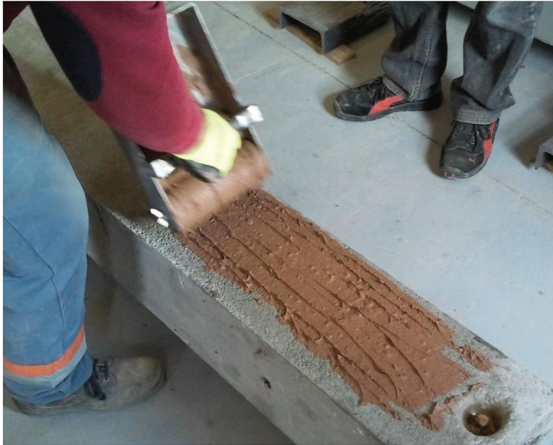
FIGURE 5.5 – Application au rouleau du mortier de joint mince sur la poutre en béton armé inférieure par un employé de la société Wienerberger.
