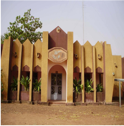
1. Entrée de la station de Radio Parana
