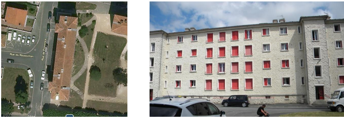
Figure 4-1 : Vue aérienne et latérale du bâtiment étudié à La Rochelle.
