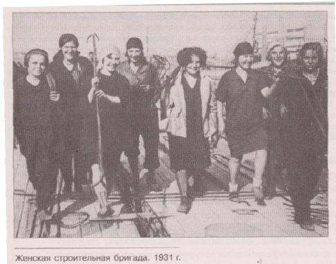
Женская строительная бригада. 1931 г.
