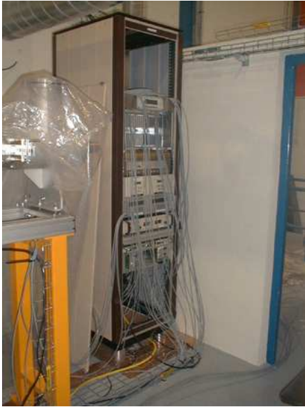
Photo N° 12: Câblage baie masse
