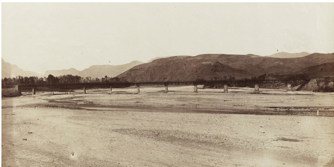
FIG. 2 MICHEL DE BERGUE. Viaducto ferroviario de Martorell sobre el río Llobregat, línea de Barcelona a Martorell (dos tramos extremos de 17 m y nueve tramos de 27,40 m), 1859. Fotografía de JOSÉ MARTÍNEZ SÁNCHEZ.
