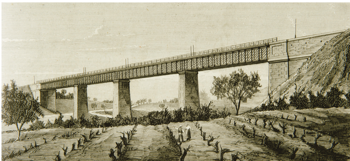
FIG. 4 JOSEP MARIA CORNET I MAS. Viaducto ferroviario de Can Palau sobre el río Congost, línea Granollers-Sant Joan de les Abadesses (dos tramos extremos de 32,54 m y dos tramos de 39 m), construido en los talleres de La Maquinista Terrestre y Marítima, 1871-1875. Biblioteca de Catalunya, La Ilustración Española y Americana , 15 sep. 1875.
