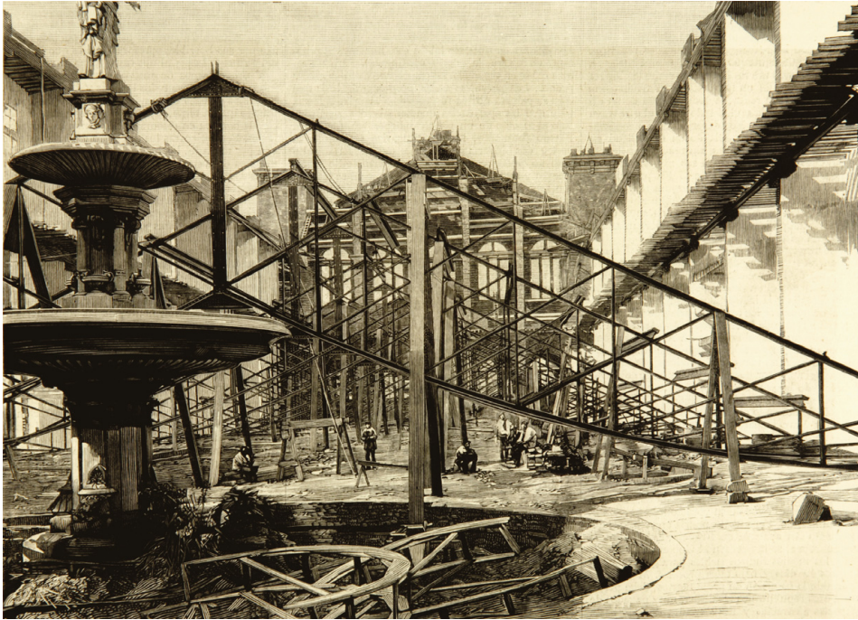
FIG. 9 JOAN TORRAS GUARDIOLA. Armaduras de «ala de mosca» a punto de ser izadas en la nave central del Palau de la Indústria de la Exposición Universal de Barcelona, 1888. La Ilustración Española y Americana , 8 de marzo de 1888.
