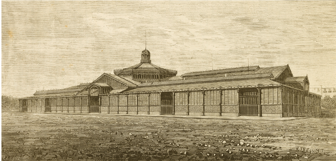
FIG. 5 JOSEP FONTSERÈ I MESTRE con JOSEP MARIA CORNET I MAS. Mercado del Born de Barcelona, construido en los talleres de La Maquinista Terrestre y Marítima, 1873-1876. Fons antic de la ETSEIB (UPC). Dibujo de ANTONIO CASTELUCHO, en C. CAMPS ARMET, Diccionario industrial. (Artes y oficios de Europa y América) , Barcelona, A. Elías y C.ª Editores, s. f., ca. 1890.
