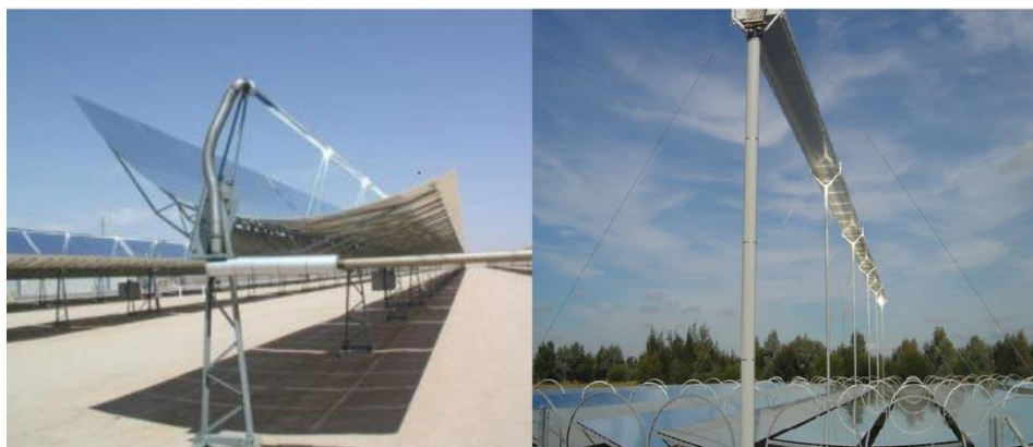
Εικόνα 3.3 – Παραβολικοί συλλέκτες και γραμμικό σύστημα συλλεκτών Fresnel (Tchanche, 2010)
