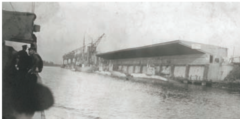
■ Un torpilleur navigue le long de quelques sous-marins de classe UB-I amarrés dans l'arrière-port de Bruges. Des apprentis construits en béton et en bois leur offraient une protection contre les attaques aériennes potentielles (Tomas Termote)
