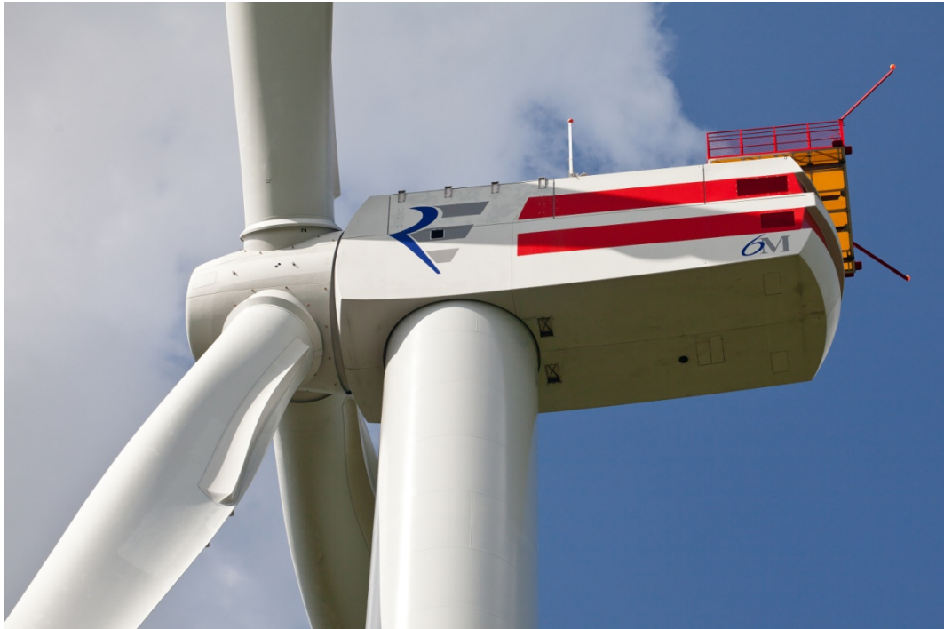
Abbildung 2.18 40 : WEA REPOWER 6M mit Spoiler am Rotorblattinnenbereich
