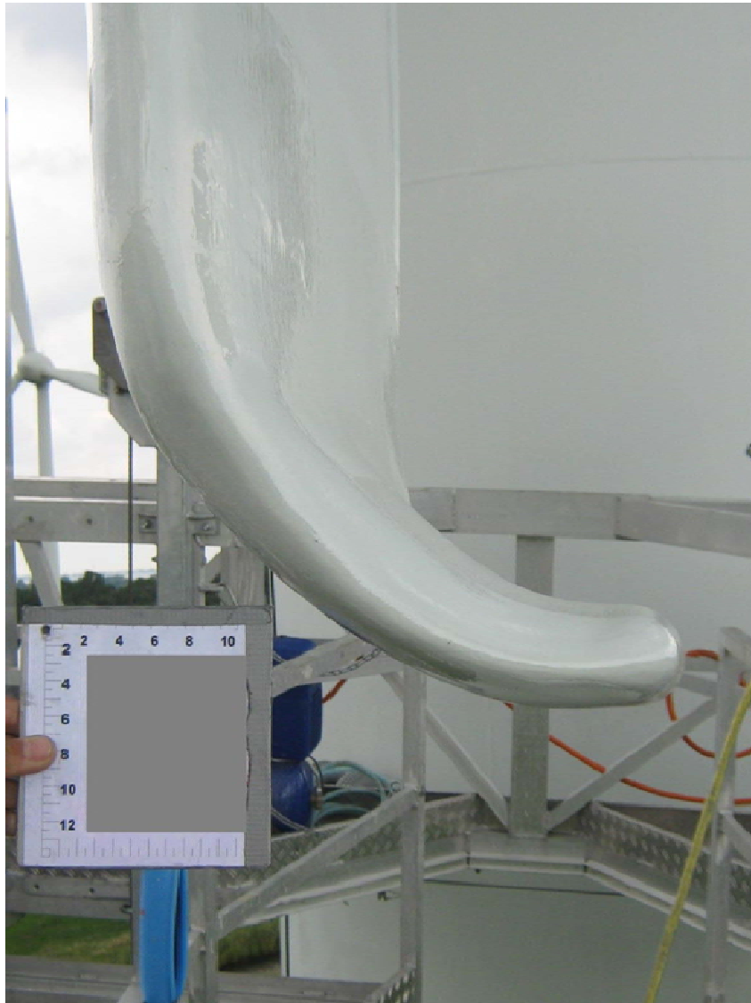
Abbildung 2.12 33 : Nachgerüstetes Winglet als Prototyp am Rotorblatt einer WEA
