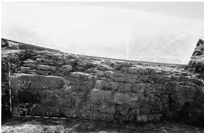
Fig. 176. Alle, Les Aiges, «phase» 1 à 4. Vue de la petite carrière (F2.1) entamant les bancs calcaires en front de taille.
