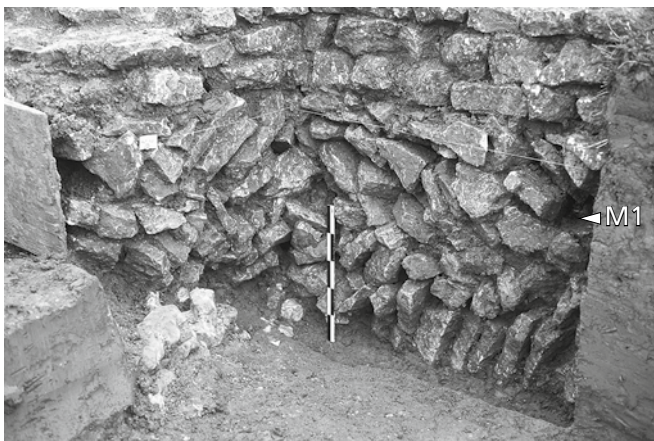
Fig. 119. Alle, Les Aiges, phase 3. Vue de la face externe du mur M1 du bâtiment 3, soutenu d'un contrefort, lié au mur. Blocs obliques : fondations ; blocs à plat : assises de réglage.
