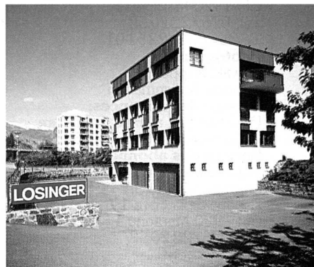
Bureaux administratifs, Sion 1988
