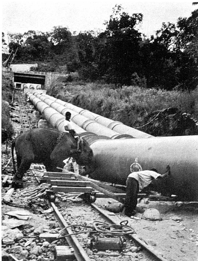
Quand l'animal vient aider l'homme : mise en place de trois conduites forcées pour la centrale de Sholayar (Inde) par Giovanola-Binny, société fondée en 1961 à Cochin
