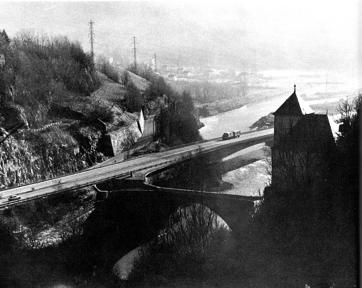
Les ponts sur le Rhône et le château de Saint-Maurice
