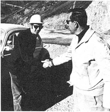
Sur le chantier : les ingénieurs Martinelli (portant casque) et Tafelmacher
