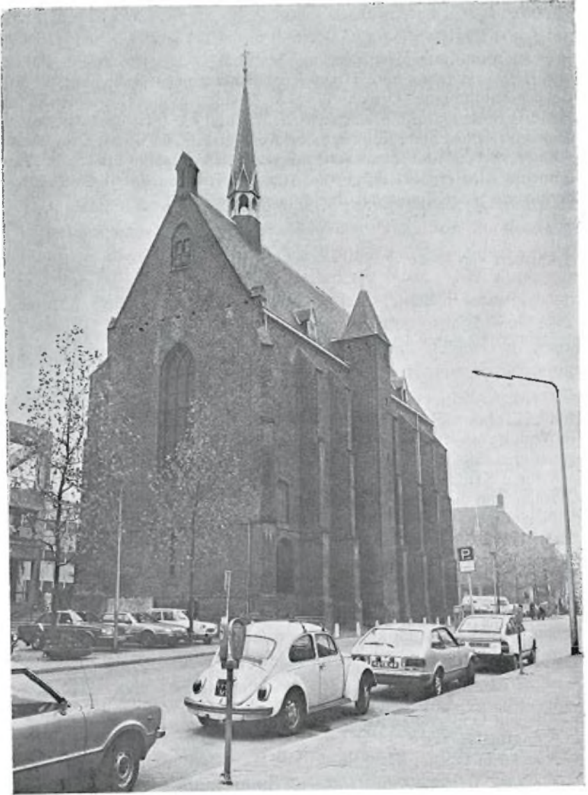
Ehem. Klosterkirche Marienburg, 1978 (Foto : GArch Nimwegen).
