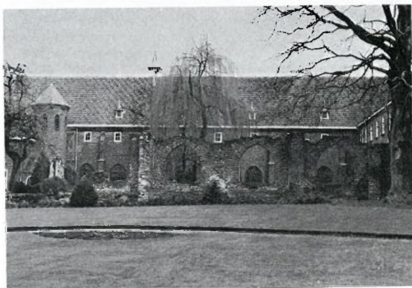
Reste der ehem. Klostergebäude, Rückseite.
