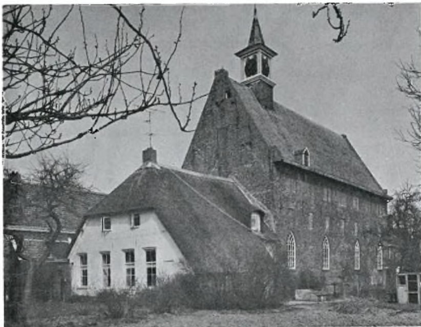
Windesheim, ehem. Klosterbrauerei (Foto : Rijksdienst Monumentenzorg, Zeist, 1971).
