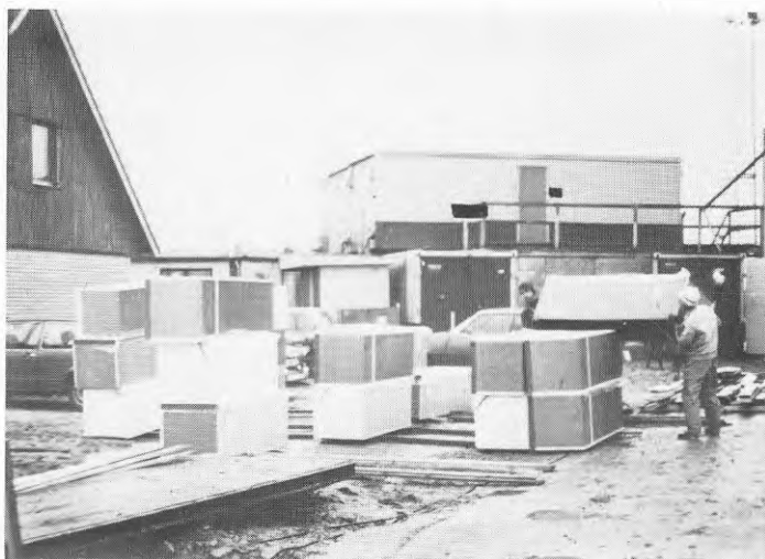
Figur 7.7 All lossning och sortering gjordes manuellt. Då skåpen köpts osorterade måste sorteringen husvis ske i regnet, och då lämpligen direkt i anslutning till lossningen, så att borttransporten till resp hus kunde starta innan alla skåp är lossade.
