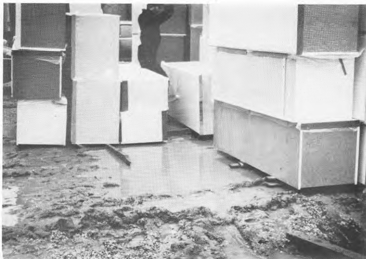
Figur 7.7 All lossning och sortering gjordes manuellt. Då skåpen köpts osorterade måste sorteringen husvis ske i regnet, och då lämpligen direkt i anslutning till lossningen, så att borttransporten till resp hus kunde starta innan alla skåp är lossade.
