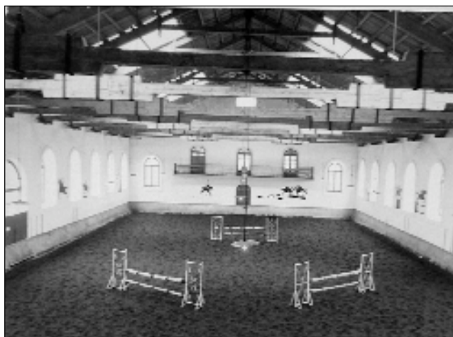
Año 1975. Las paredes estaban pintadas con cal. En la década de los 80 se eliminó ésta, para dejar al descubierto el ladrillo de sus paredes
