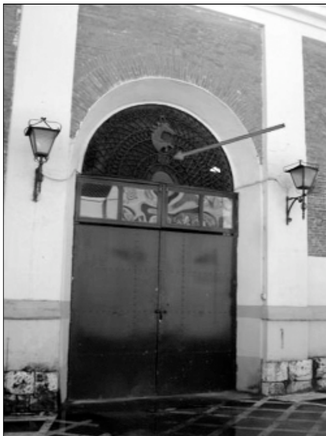
Puerta de acceso, lado norte, donde puede apreciarse en la parte superior de la misma el año de finalización de su construcción, 1861
