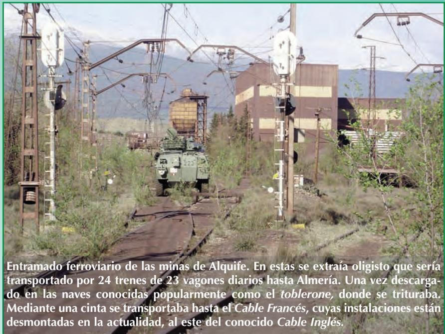
Entramado ferroviario de las minas de Alquife. En estas se extraía oligisto que sería transportado por 24 trenes de 23 vagones diarios hasta Almería. Una vez descargado en las naves conocidas popularmente como el *toblerone*, donde se trituraba. Mediante una cinta se transportaba hasta el *Cable Francés*, cuyas instalaciones están desmontadas en la actualidad, al este del conocido *Cable Inglés*.
