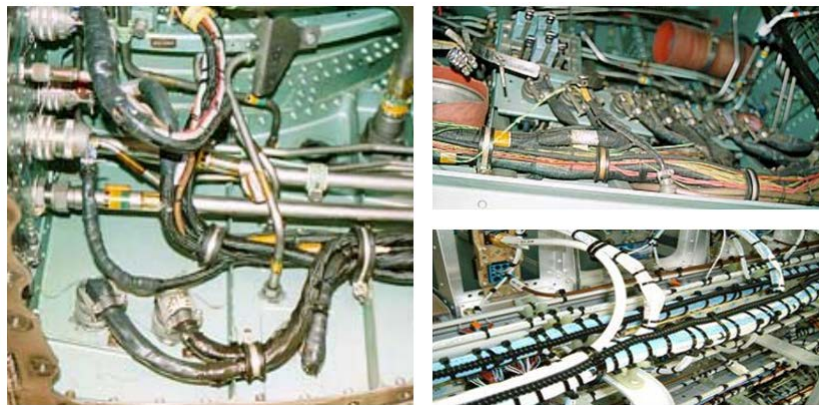
FIGURE 1.5: Exemple de câblage dans le domaine aéronautique [5].
