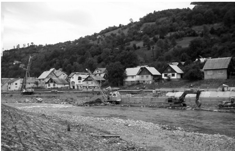
Gátépítés a Tiszán Rahónál
