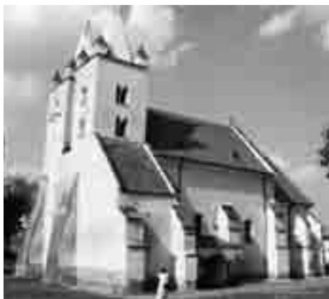
Árpádkori, ma is működő templom Csallóközséi-törtőkön
