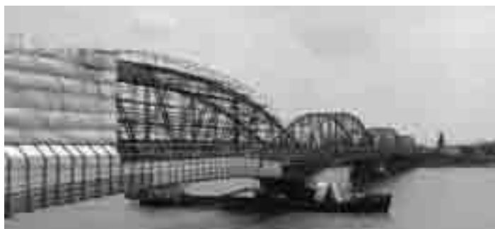
A komáromi közúti híd
