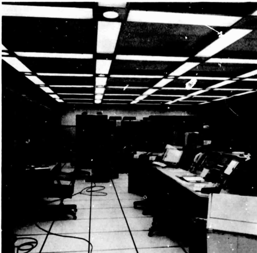
Interior de la Instalación de Cebreros
