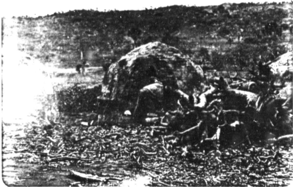
Fig. 55 - Fechamento de um forno para dar início ao processo de queima.
