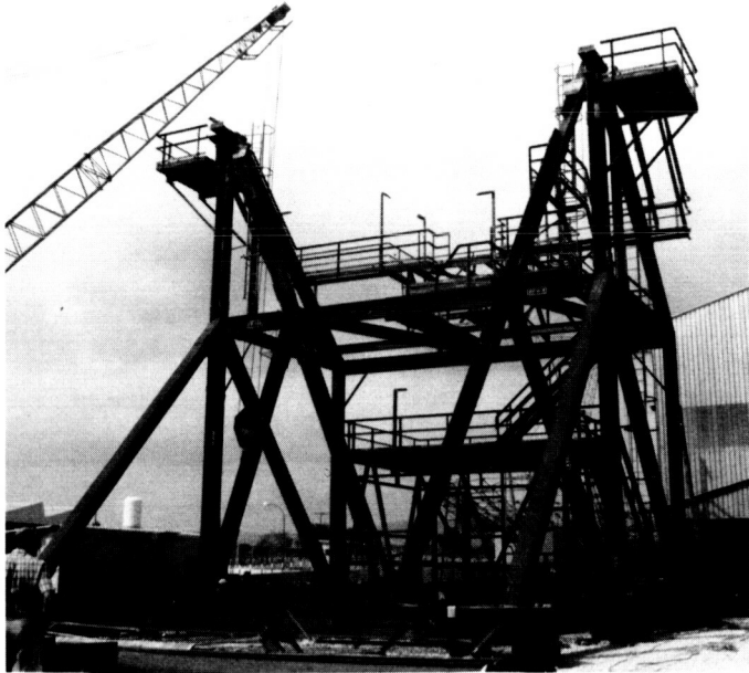
Fig. 4. Alidade structure assembly fit-check, DSS 65
