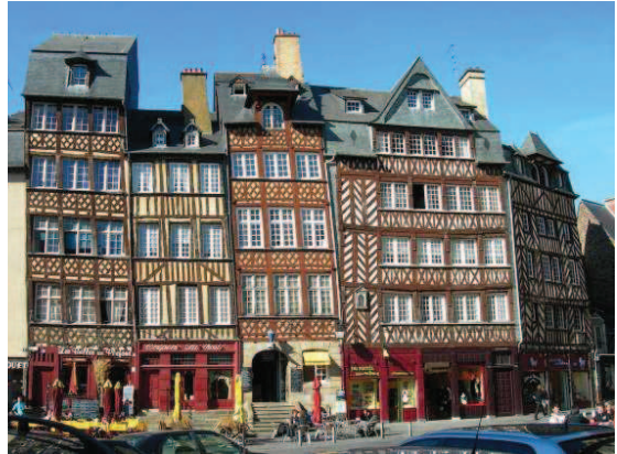
Figura 2.17: Construcción a paneles de madera en el centro de Rennes (Bretagne)
