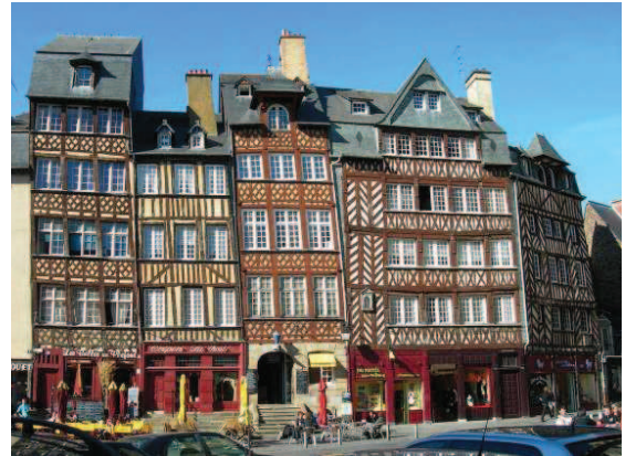
Figure 2.17 : Bâtisses à pans de bois dans le centre de Rennes (Bretagne)
