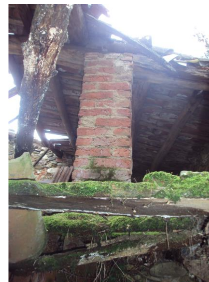
Imatge 9 del pilar de maó
