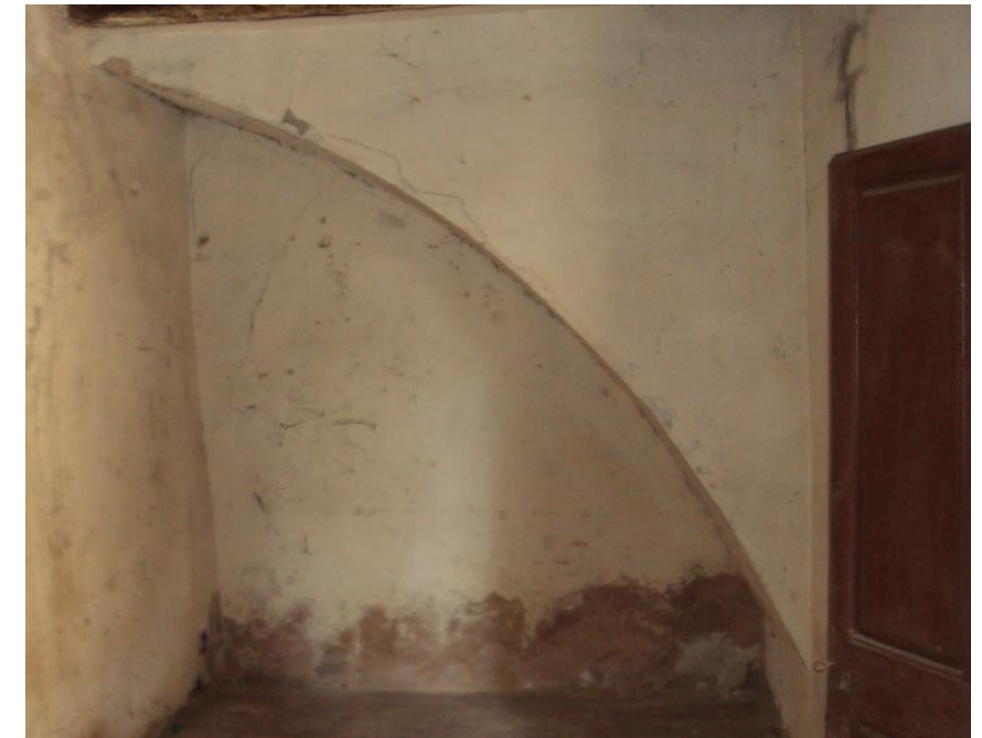
Les escales construïdes amb volta de maó pla
