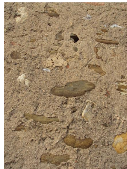
Imatge 8 del detall de paret exterior.
