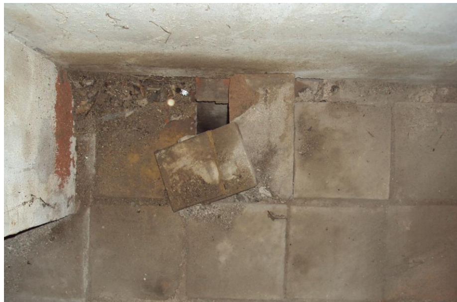
Imatge 54: paviment habitació 5
