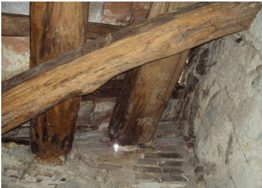
Imatge 57: Bigues BH6-07 i BH6-08
