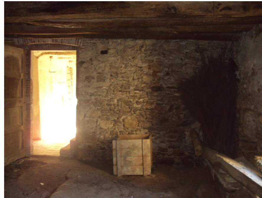
Els murs de paredat vist a l'interior
