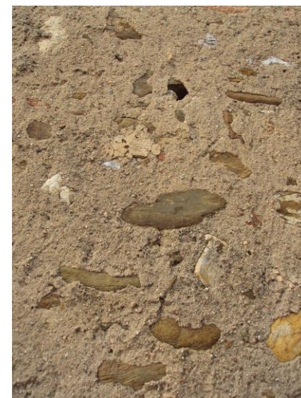
Imatge 8 del detall de paret exterior.
