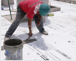
Es un aislante térmico a base de espuma rígida en presentación de placa que se adapta al sistemas de construcción tradicional de concreto armado.
