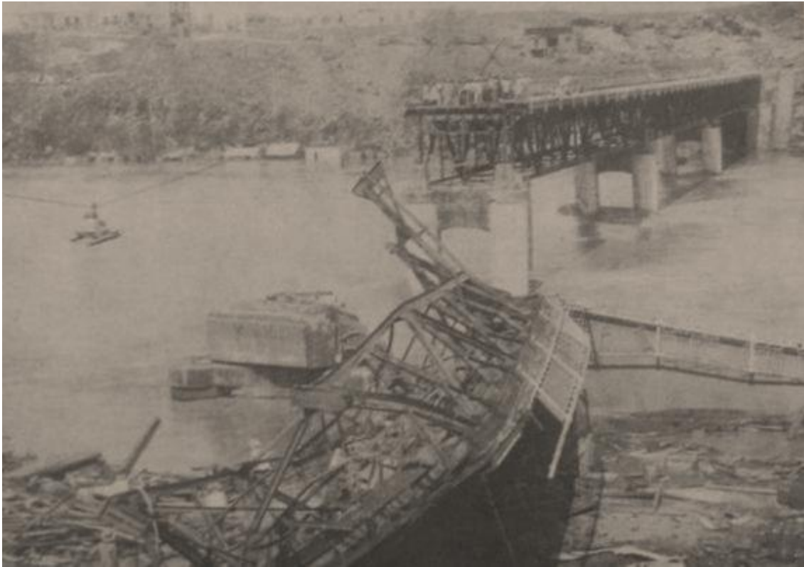
Figura 15. Destrucción del Puente Ozama luego del ciclón de San Zenón en 1930
