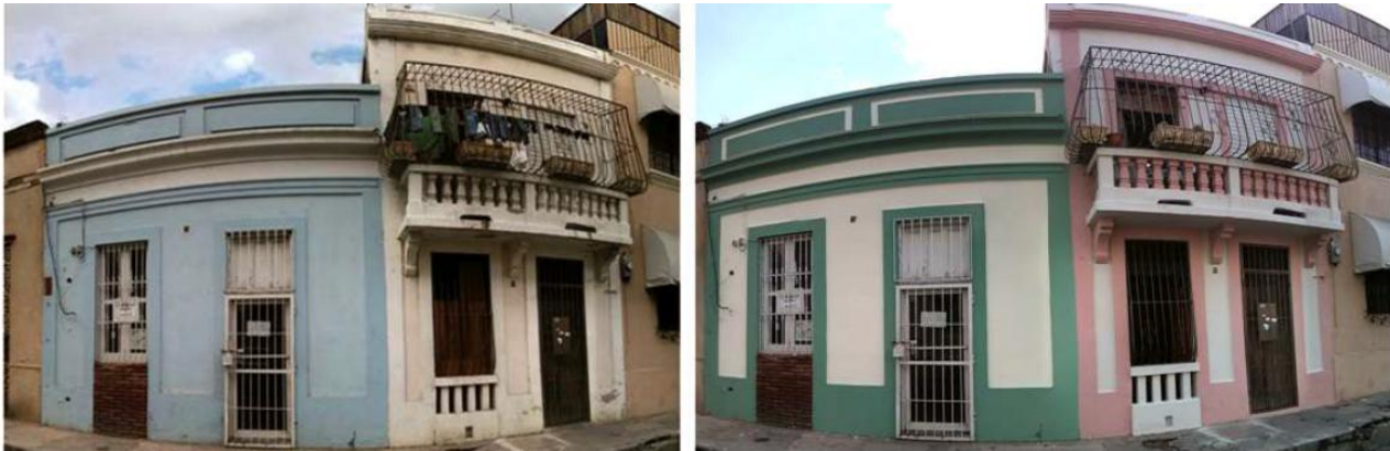
Figura 41. Antes y Después de la fachada histórica
