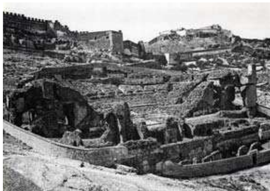
Estat del teatre abans de la intervenció (1986)
