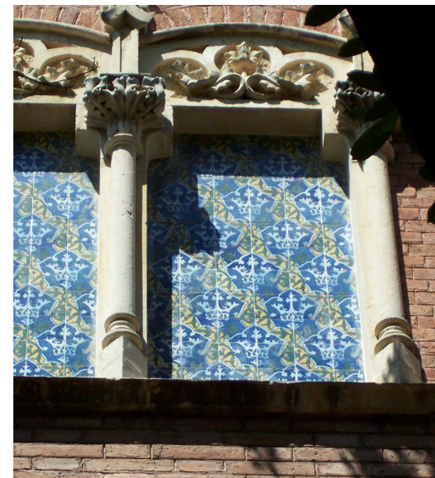
Decoración de oberturas mediante alicatado
