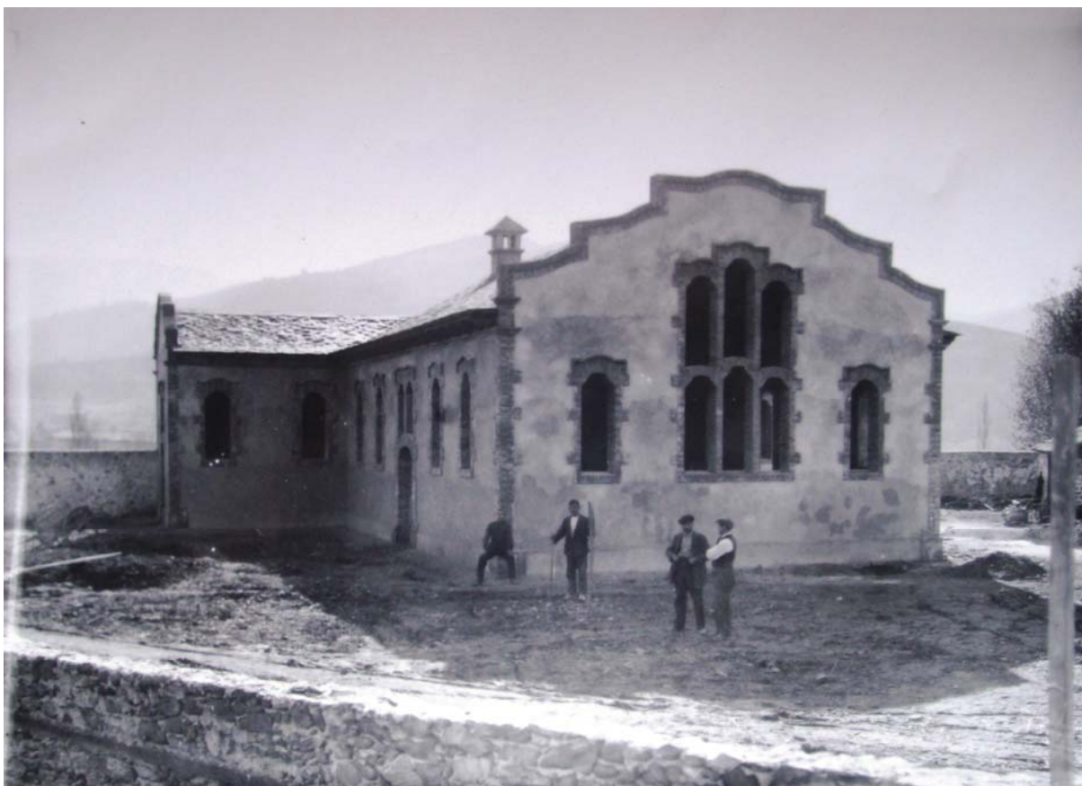
En aquesta fotografia s'hi poden veure millor els murs de paredat formigonat i la composició de la façana principal, a cara Nord, amb el coronament i el conjunt d'obertures.
