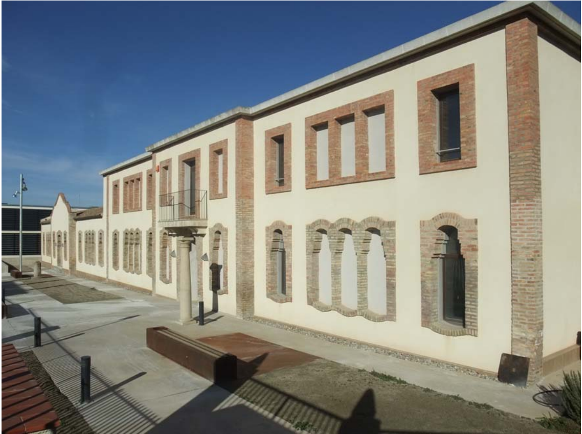
Façana principal de l'edifici. Amb el bloc inicial al fons i la tercera ampliació a primer pla
