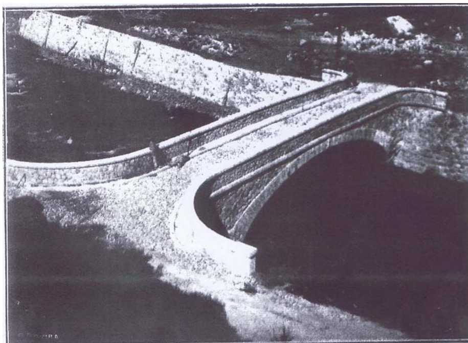
F6. Pont realitzat per Joan Bergós a la central elèctrica de Cledes. 1923
