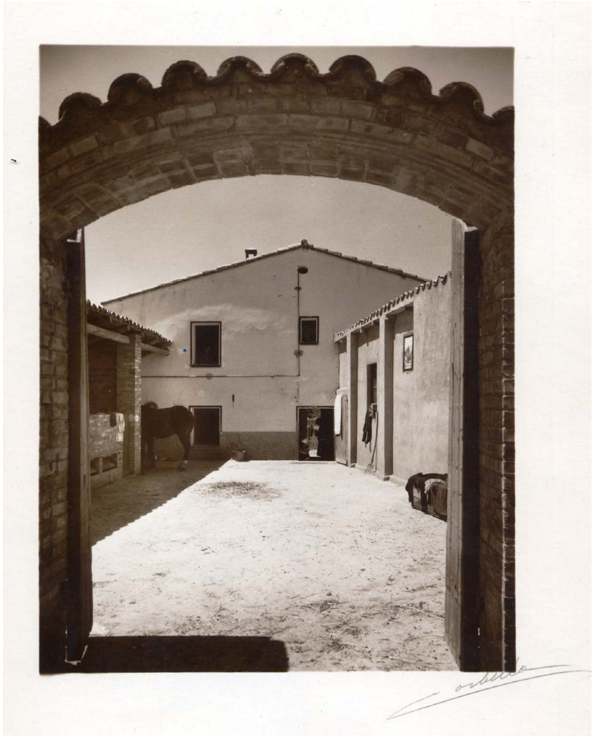
Entrada a les quadres i finalment a l'habitatge
