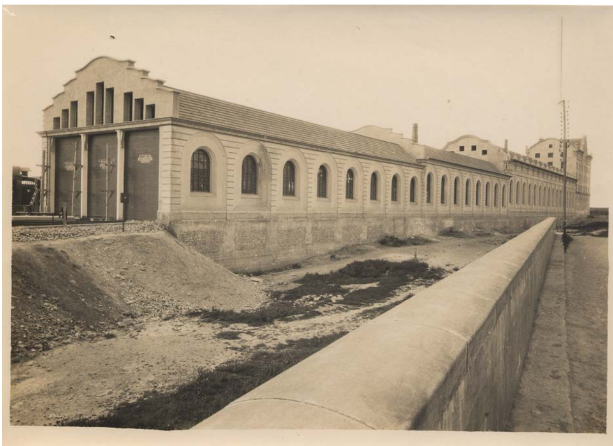
F11. Edifici de les cotxeres de l'Hospitalet, realitzat per Joan Bergós. 1926
