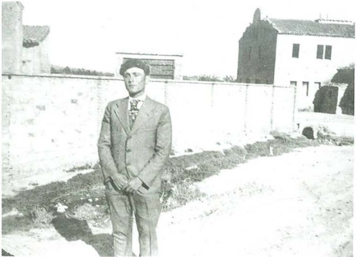
Aquesta és l'única fotografia que es conserva de l'edifici. Es suposa que deu ser de la dècada del 1920
