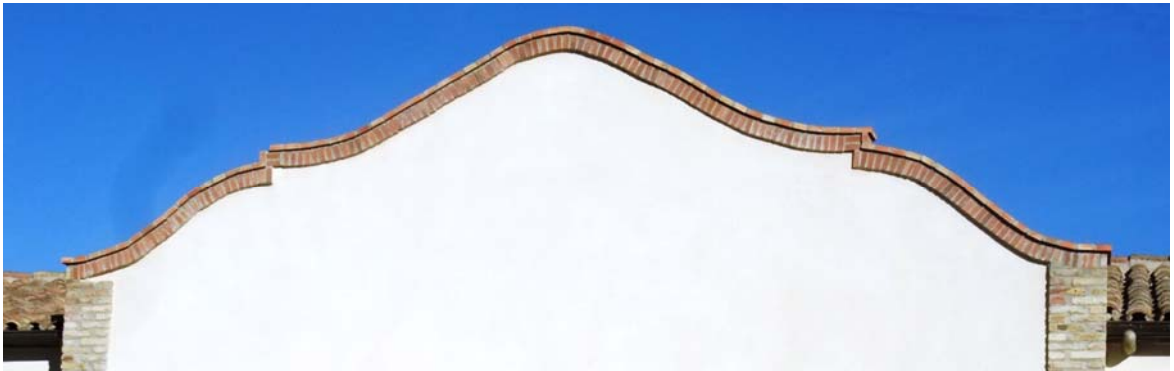
Coronament de l'entrada original. Conjunt d'arcs rebaixats, escalonats i partits
