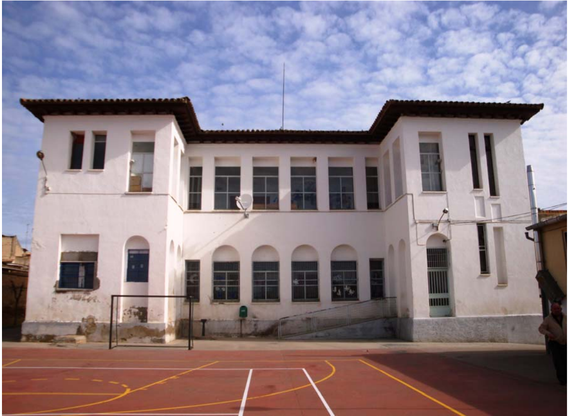
Façana principal de l'edifici. On les obertures varien més de forma. Dóna al pati
