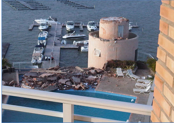
Figura 1. Edificaciones dañadas por el terremoto de Tucacas (2009)
