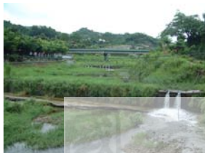
圖 1 規模不當的固床工工法。連續性固床工本身的安全堪虞且河道紋亂，魚類也恐難存活。
